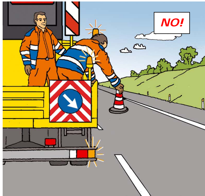
Figura 60 – Posizionamento dei coni o defleco: comportamento scorretto
